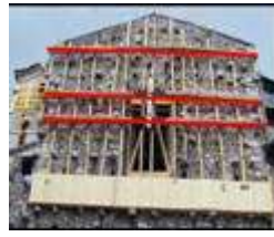
Esempi di cerchiatura con elementi lignei o metallici e funi in acciaio
