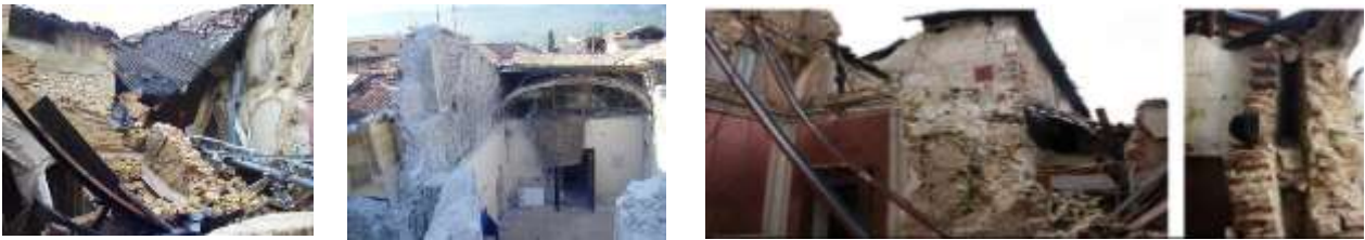
Foto dei paramenti murari
