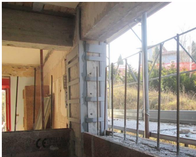
Figura 8: Posa in opera delle pareti in blocchi-cassero
