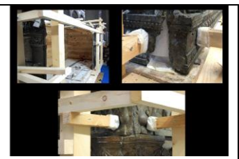
Figura 30: Particolari messa in sicurezza
